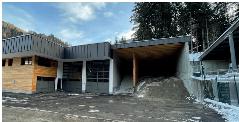
Cantier de Comun
